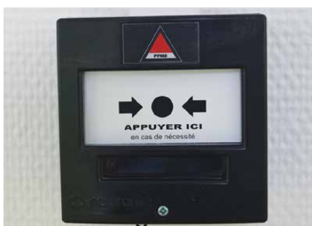
Pose de boîtiers d'alarme sécurité PPMS
