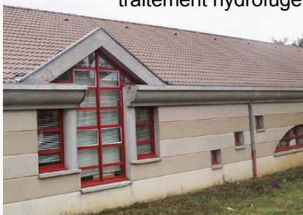
Etat de la toiture après traitement hydrofuge
