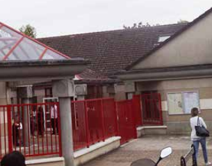
Etat de la toiture avant traitement
