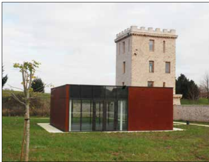
La Tour Maury après les travaux
